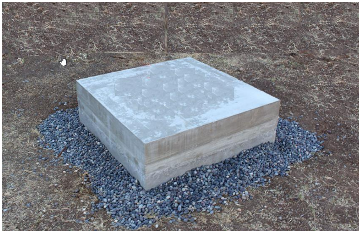
Рисунок 5 Блок основания фундамента (кирпич, жби блок)
